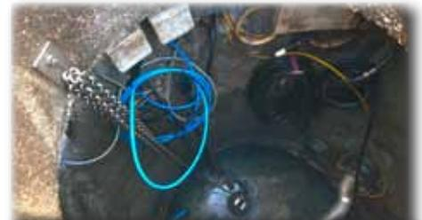
Sämtliche elektrische Anschlüsse mussten explosionsicher ausgeführt werden
