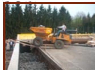
12. April: Die Stützmauer und Fundamentplatte für die Fußballkabinen werden betoniert dazu werden 66m<sup>3</sup> Fertigbeton benötigt.
